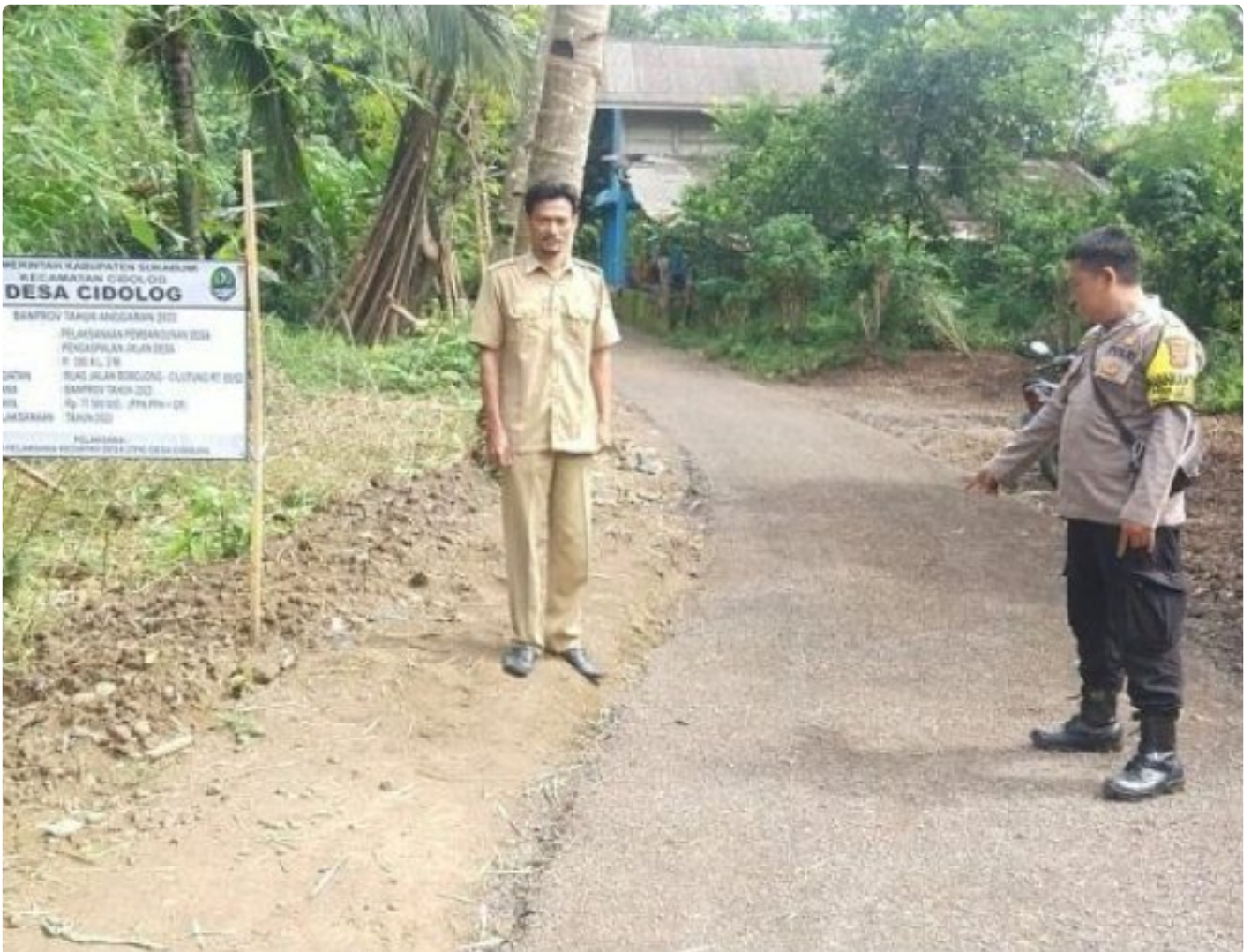
Bhabinkamtibmas Desa Cidolog Awasi Pembangunan Desa
