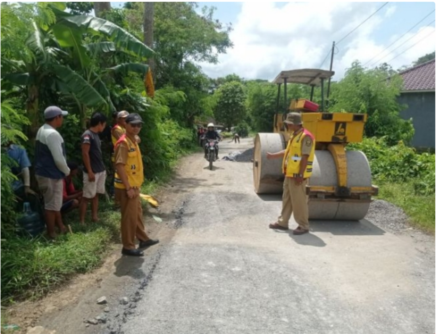
Dinas PU Kabupaten Sukabumi Perbaiki Jalan Rusak di Wilayah Jampangkulon.
